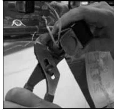
Loosening the conduit nut
